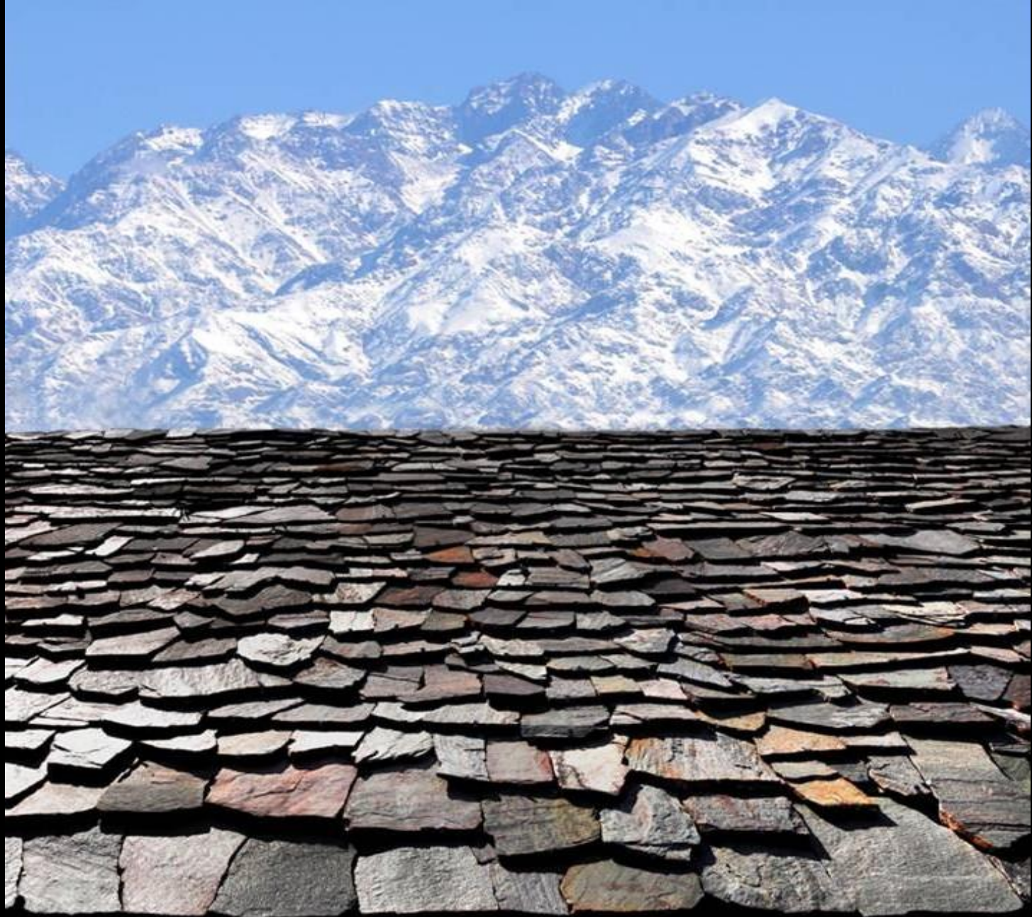
Bodega Atamisque - Bórmida & Yanzón -Mendoza
